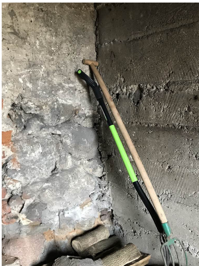
Fundament dobudowanej części budynku – betonowy
