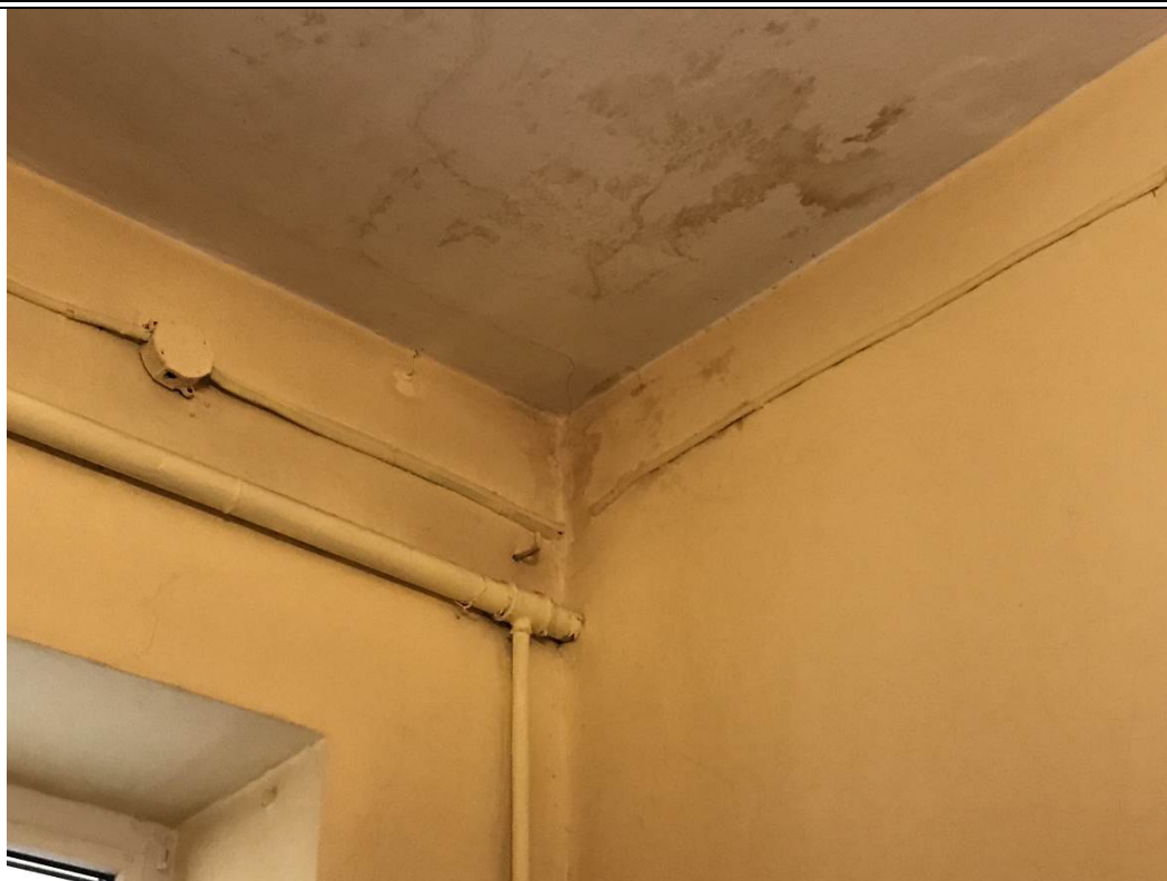
Zacieki od nieszczelnego dachu na suficie
