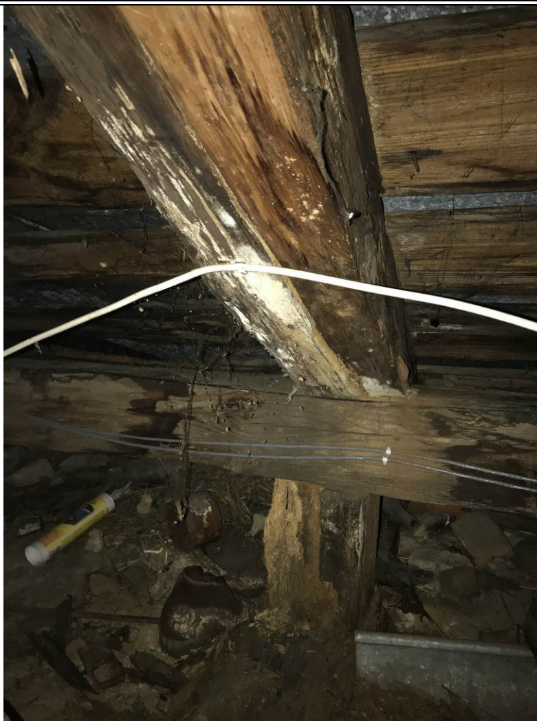
Fragment uszkodzonych elementów więźby.
